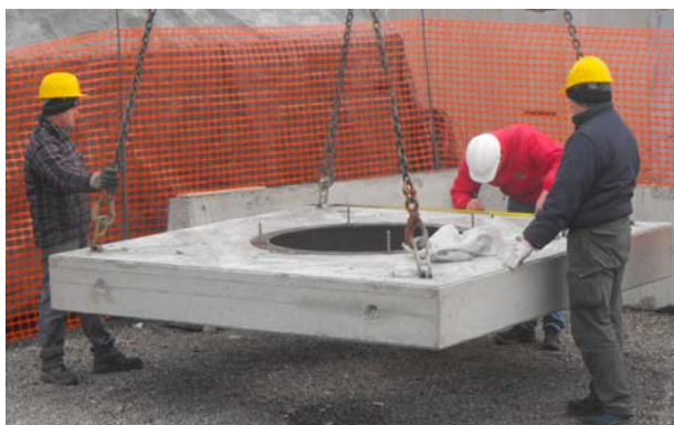
Figura 3. Posa del basamento prefabbricato attrezzato con appositi ganci per il sollevamento e la movimentazione.
