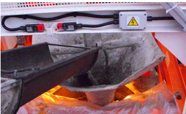
Figura 9. Fase di getto del palo: modalità con canale dell'autobetoniera posizionata sul fianco del Verticalatore.
