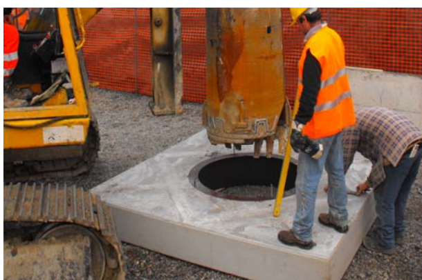
Figura 4. Scavo di approccio. Il basamento prefabbricato è attrezzato con un anello guida o dima in acciaio appositamente dimensionata per minimizzare gli errori di posizionamento planimetrico.
