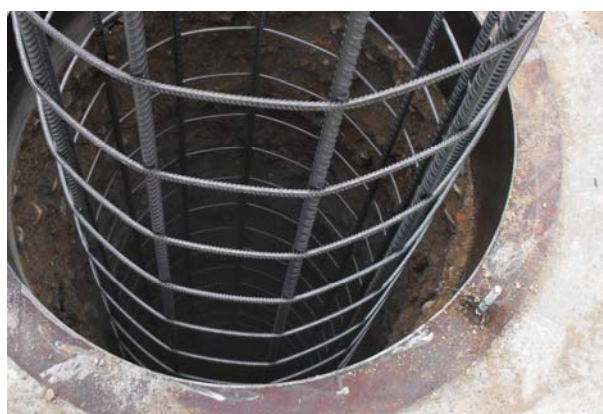
Figura 6. Posizionamento finale alla quota di progetto della gabbia d'armatura del palo.
