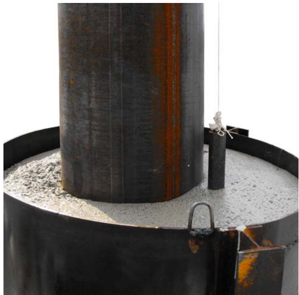
Figura 1. Affondo del pilastro nel calcestruzzo fresco del palo.
