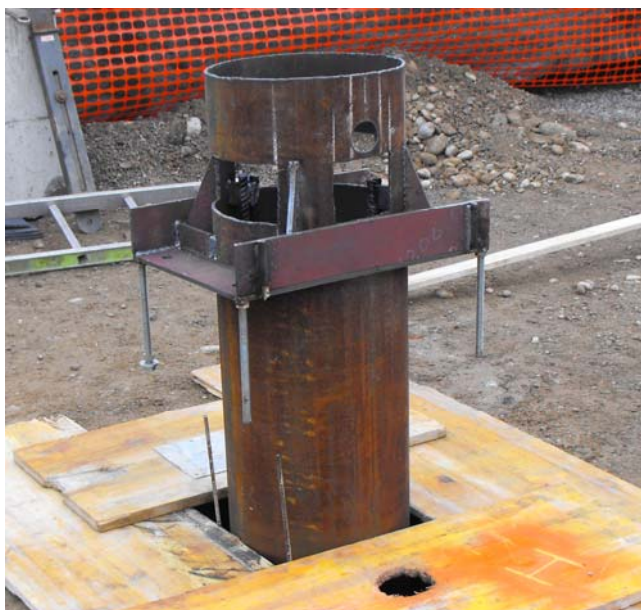
Figura 11. posizione finale del pilastro PCM attrezzato con mensole in acciaio per il fissaggio del pilastro al Verticalatore (barre filettate di regolazione) e per il supporto delle Travi PREM in fase finale.
