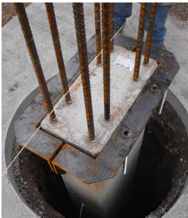
Figura 10. posizionamento finale del pilastro prefabbricato corredato da mensole a collare rimovibili e verifica della corrispondenza con il tracciamento di progetto.
