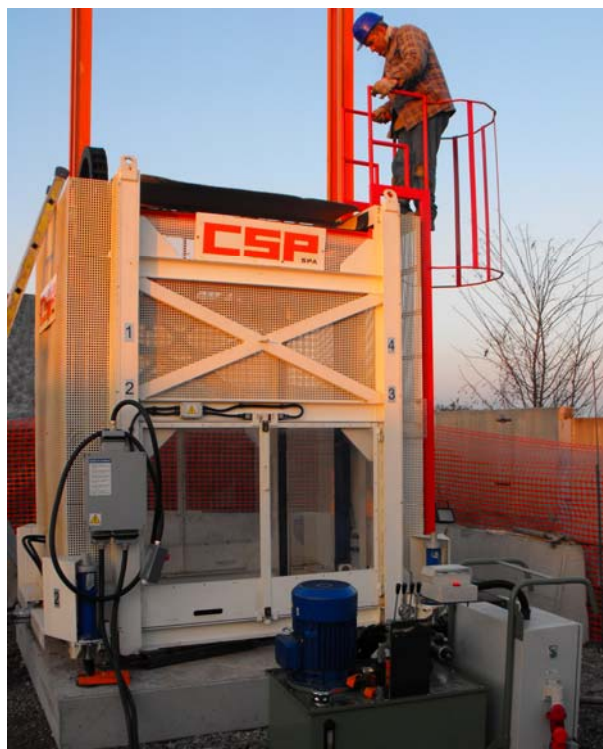
Figura 5. installazione del "Verticalatore" e della centralina per le operazioni preliminari di regolazione altimetrica. Il "Verticalatore" è dotato di sistema idraulico autolivellante mediante quattro martinetti idraulici.
