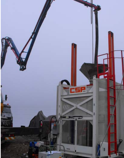
Figura 7. Fase di getto del palo: modalità con tramoggia collegata al tubogetto e beton-pompa dall'alto.
